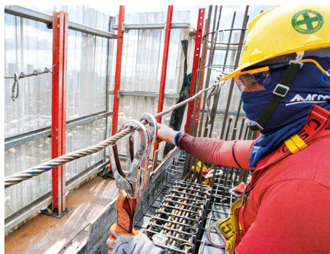
Un operario de MDBI Construction se desengancha después de que MGS-H se desplazara al siguiente nivel y proporcionara protección completa.
