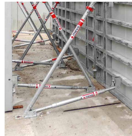
A sokoldalú gyorsanker a legkülönbözőbb rögzítésekhez, itt pl. az oldaltámaszokhoz, is felhasználható.
