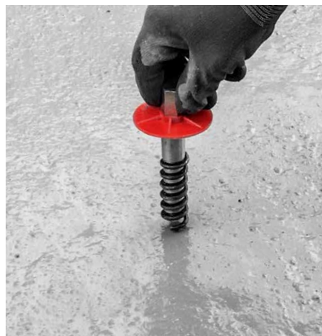
1. felhasználási mód – A gyorsankert a friss betonba nyomják. A szükséges betonfedést az anker-korong beállításával biztosítják
