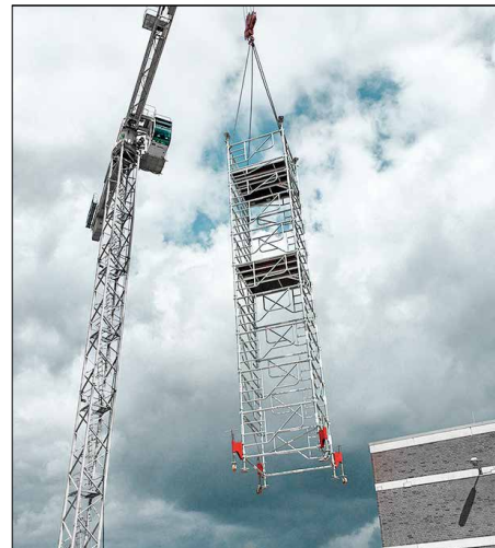
Anneaux de levage intégrés sur chaque cadre
