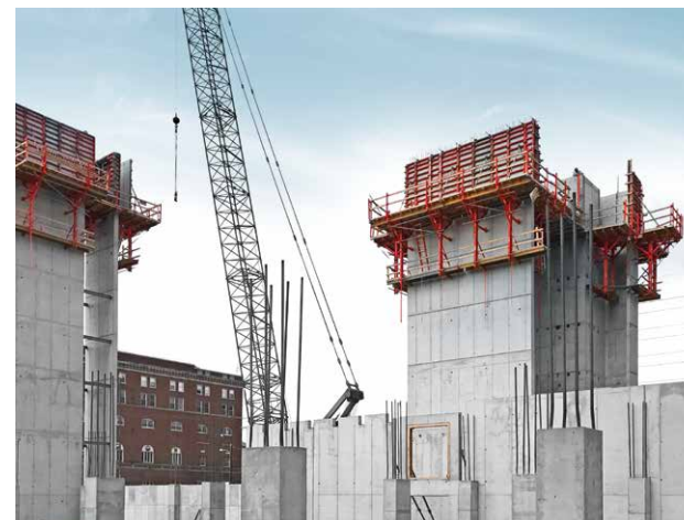
L'échafaudage grim pant KLK 230 est composé de consoles grim pantes, d'étais muraux, d'un platelage et de garde-corps.
