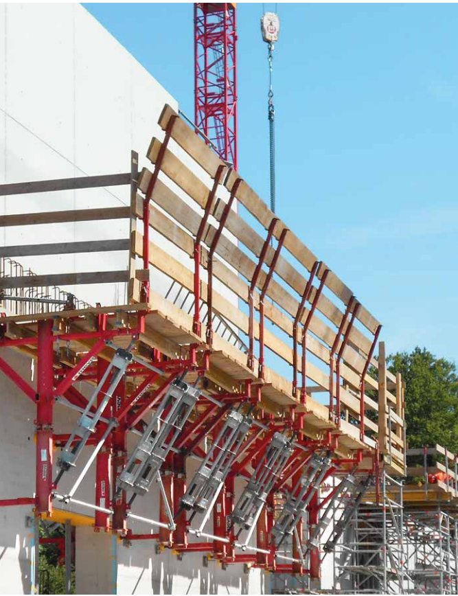
La console grimpeuse KLK 230 a été utilisée en tant que plateforme de travail pour parfaire l'alignement du coffrage.
