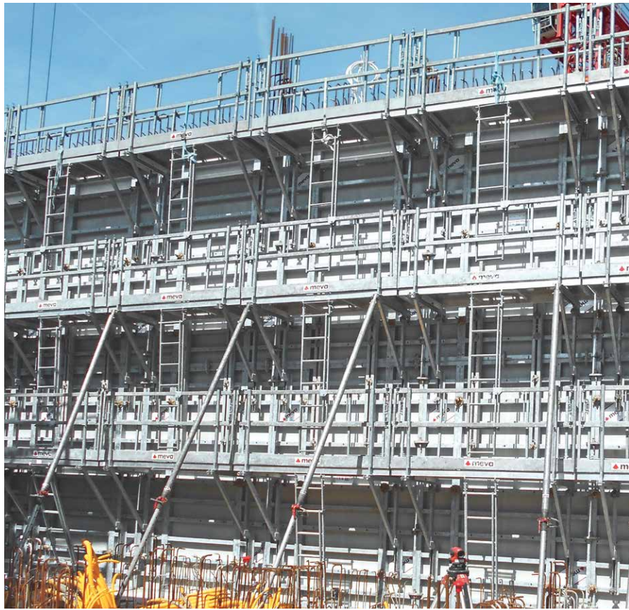
Grâce à la stabilité et la résistance élevées du coffrage Mammuth 350, le béton a pu être coulé jusqu'à une hauteur de 4 m sans faire attention à la vitesse de remplissage.
