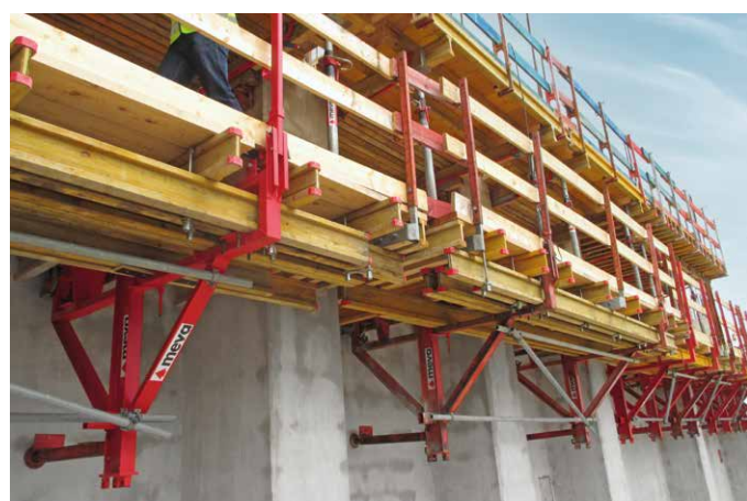
Les plates-formes de travail repliables KAB 190 (photo du haut) et l'échafaudage grimpant KLK 230, qui a pu être adapté parfaitement aux irrégularités de l'ouvrage, ont permis de disposer d'un grand espace de travail.
