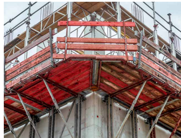
Avec 190 cm de large, la plate-forme de travail offre encore suffisamment de place, même équipée d'un coffrage ou d'un échafaudage. Les plates-formes d'angle peuvent être mises en œuvre sur des ouvrages à angles droits, à angles obtus ou à angles aigus.
