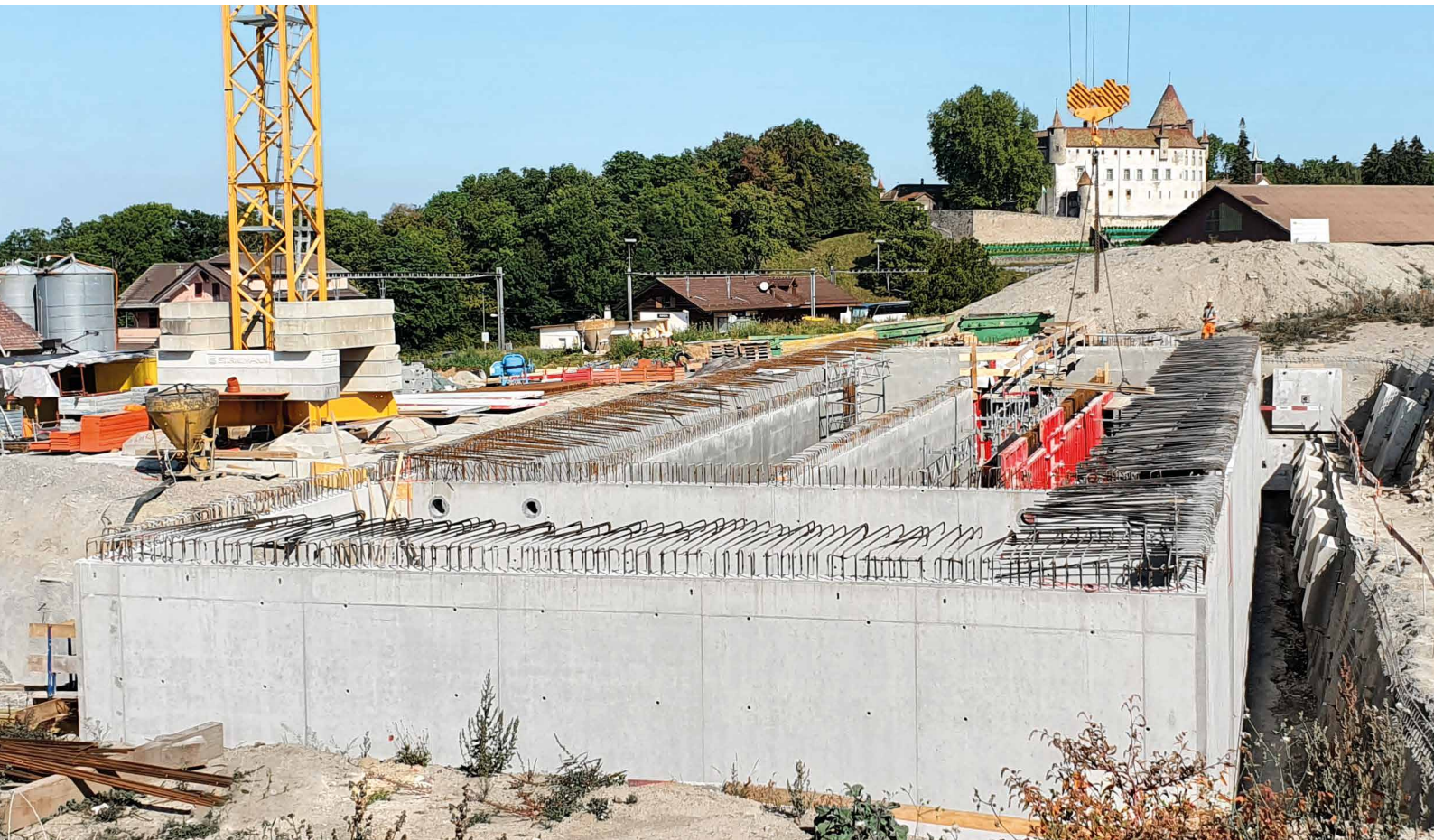
Photo du haut: le bâtiment a été érigé dans une fouille très exigüe. Au premier plan le local de ventilation, derrière le réservoir d'eau et ses voiles de refend longitudinaux. Photo du bas: le coffrage Mammuth 350 a permis de couler rapidement et sans le moindre accroc les épais voiles de 6,60 m de haut.
