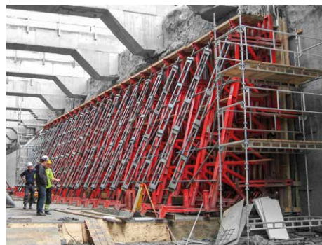
Étalement de voiles une face jusqu'à 13,50 m de haut.
