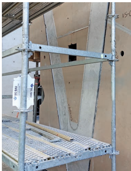
Arriba: Puntal en forma de V y cajones de moldeado tras haber retirado el encofrado de cierre. A la derecha: Puntal en V de 50 cm de ancho debajo de una viga dentada de 70 cm de ancho.
