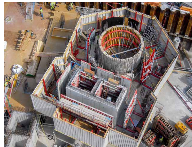
El sistema trepante MGC-H permite realizar muy fácilmente geometrías complejas con dimensiones variables y componentes desplazados.
