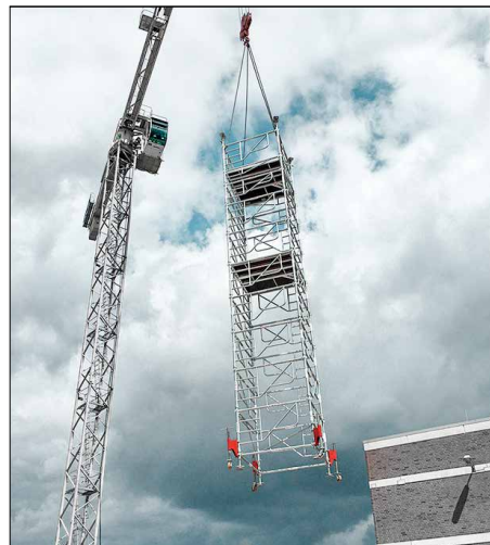
Argollas integradas en cada marco para el izado con grúas
