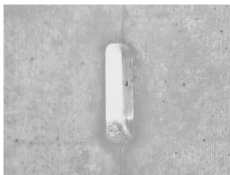
Detalle de desencofrado
