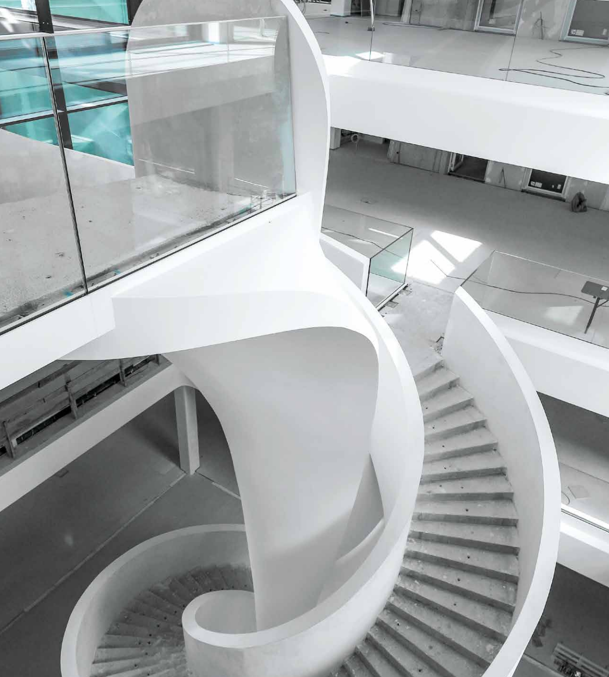
Escalera de la AUMA en Müllheim, Alemania. El proceso exacto de vaciado de concreto se realizó en ciclos de encofrado practicables, con puntualidad y a satisfacción del cliente, del arquitecto y de la contratista.
