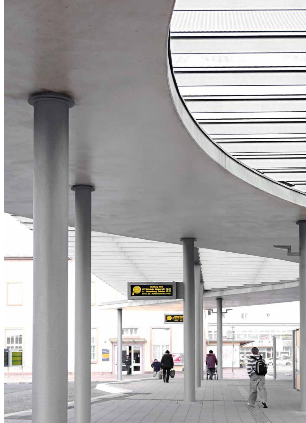
Estación de autobuses en Merseburg, Alemania Con tableros alkus optimizados geométricamente, recortados a precisión, se encofraron 760 m 2 de losa de concreto arquitectónico en calidad SB4 y sin juntas.
