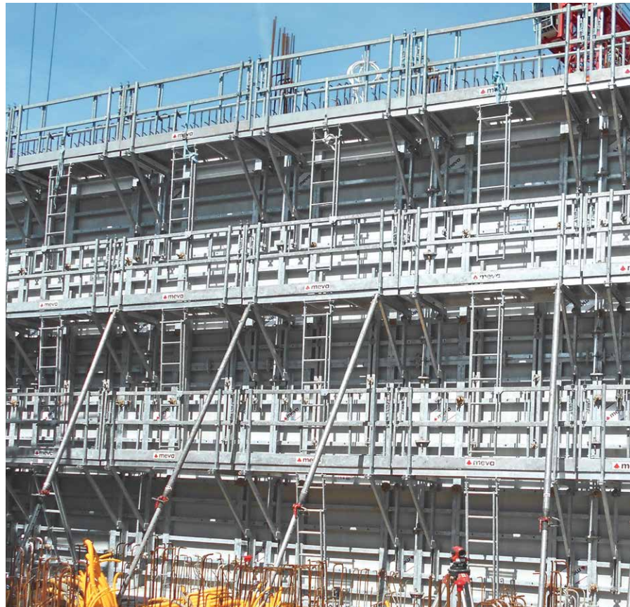
Gracias a la elevada tolerancia dimensional y a la eficiencia de Mammut 350, se pudo encofrar hasta 4 m de altura sin prestar atención a la velocidad de vaciado.
