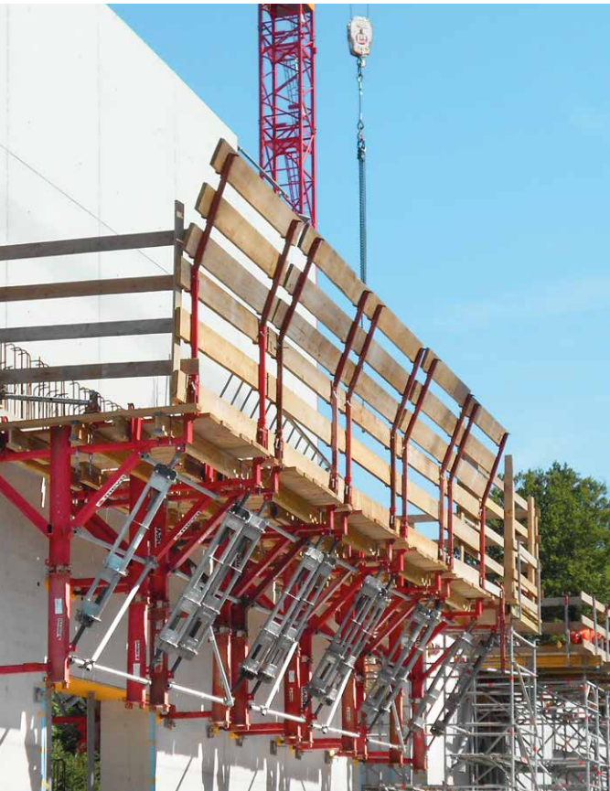
El andamio trepante KLK 230 se utilizó como andamio de trabajo libre de obstáculos para la alineación exacta del encofrado.
