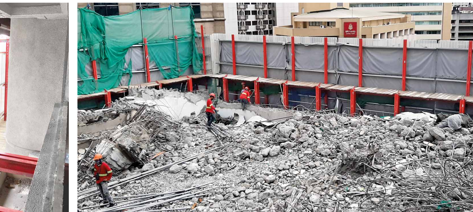
Trabajos de demolición en una de las 21 plantas: El sistema MGS permitió un desmantelamiento seguro y rápido, al tiempo que protegió el entorno.
