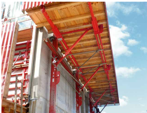
Siempre fijado al edificio, tanto en la fase de construcción como durante el ascenso.
