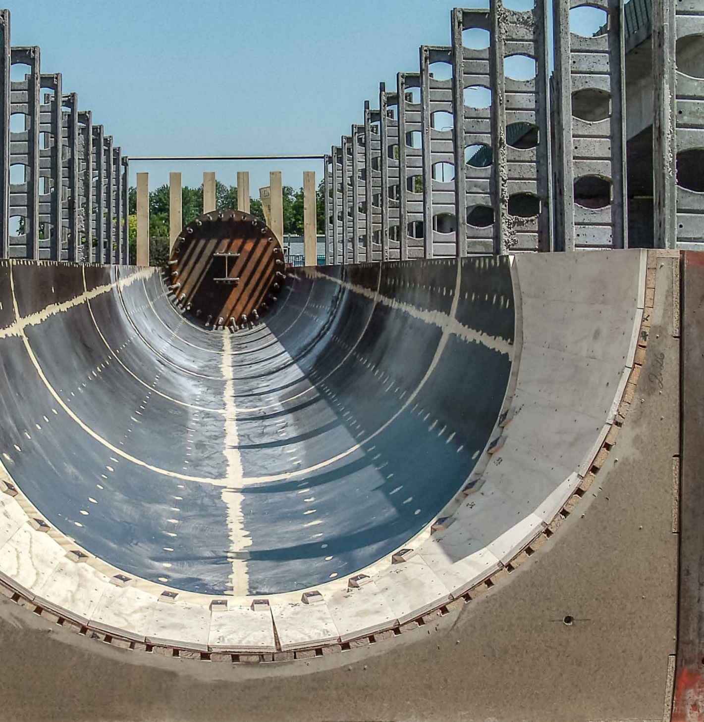
Sonderschalung aus Holz für die Fertigteilproduktion.
