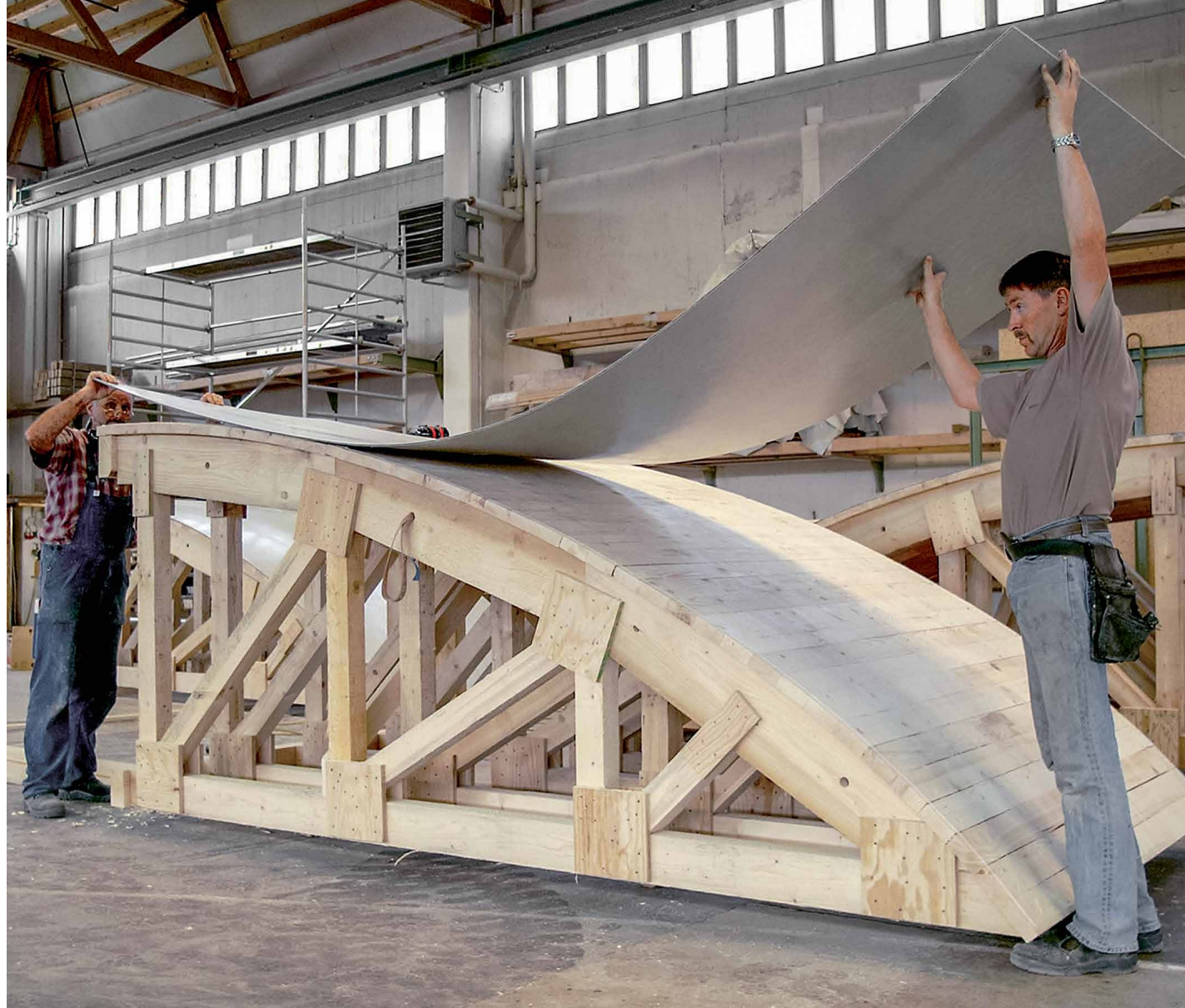
Großflächige alkus Vollkunststoff-Platte 6 mm (GM) auf einer Holzunterkonstruktion.
