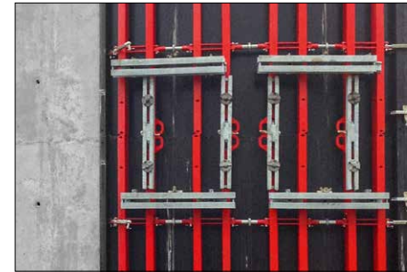
Einfache Aufstockung mit Richtschiene RS und M-Schalschloss
