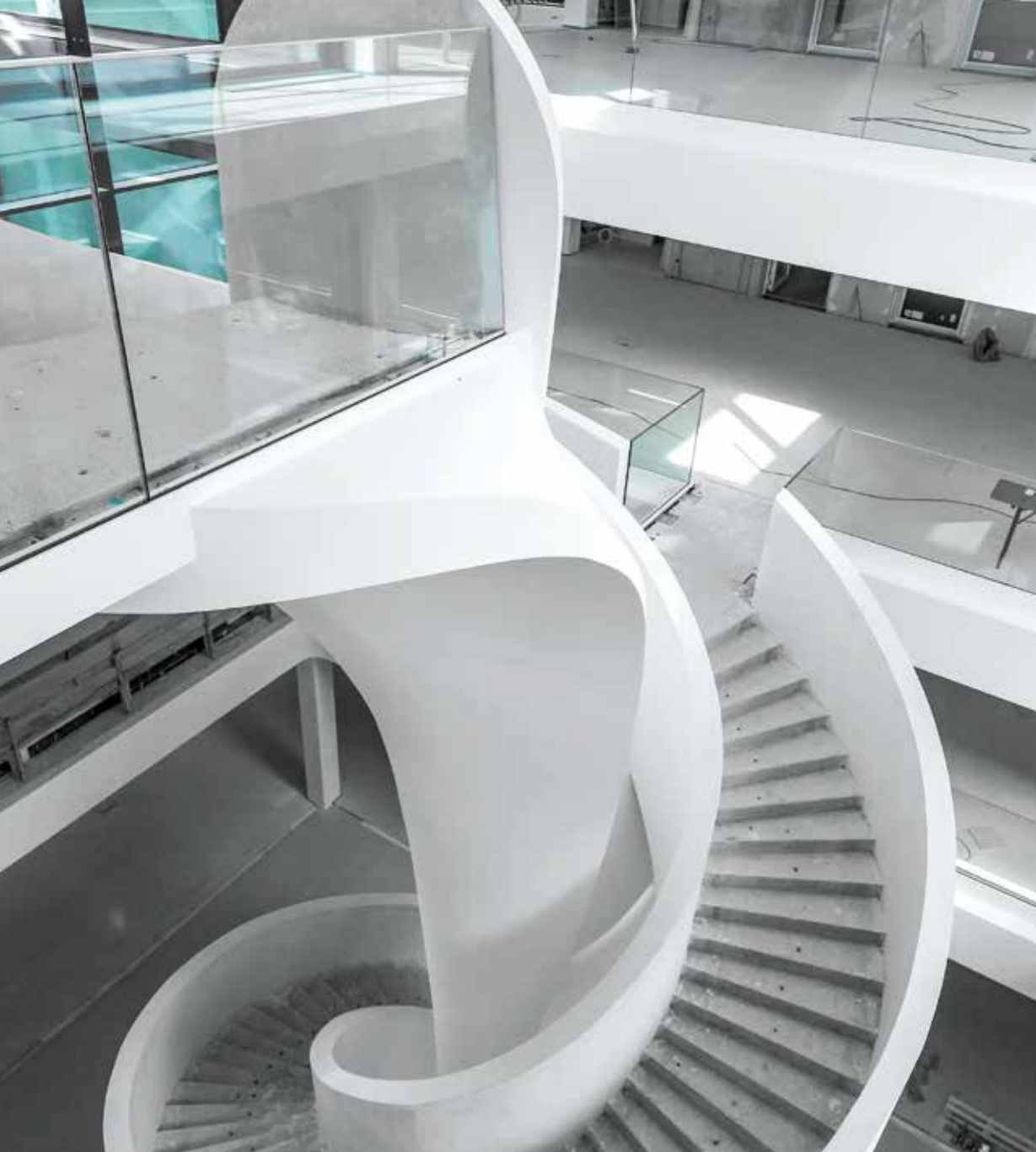
Treppenaufgang bei AUMA in Müllheim/D Der genaue Betonierablauf wurde mit praktikablen Schalungseinheiten geplant sowie pünktlich und zur Zufriedenheit von Bauherr, Architekt und Bauunternehmen umgesetzt.
