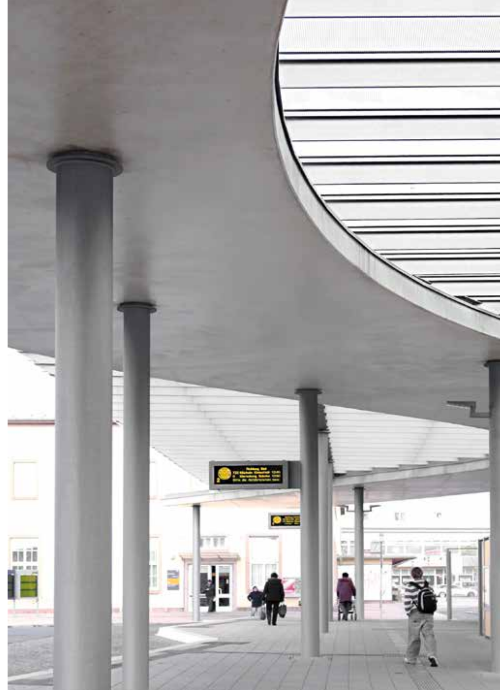
Busbahnhof in Merseburg/D Mit geometrisch optimierten, exakt geschnittenen und verschweißten alkus-Platten wurden 760 m 2 Sichtbetondecke fugenlos in SB4-Qualität erstellt.
