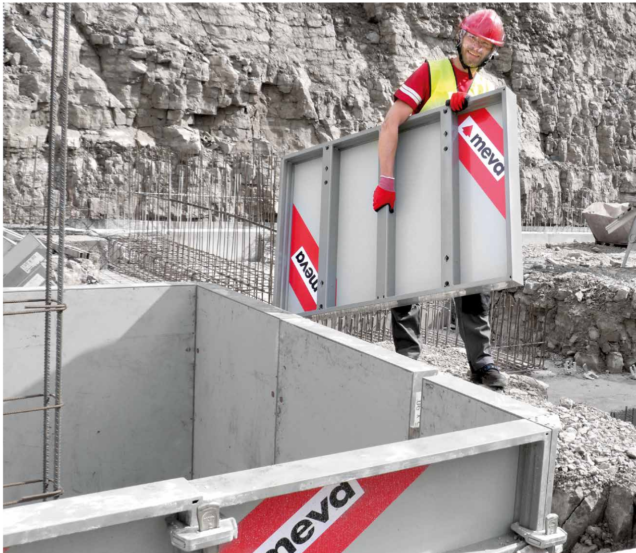
Das geringe Gewicht der Elemente und das ergonomische Griffprofil ermöglichen kraftschonendes, sicheres Arbeiten.
