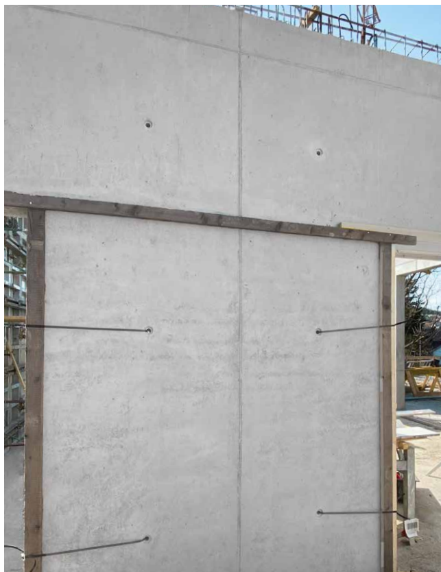
Die Wandflächen wurden mit harmonischem Anker- und Fugenbild und in Sichtbetonqualität SB3 zügig und reibungslos errichtet.
