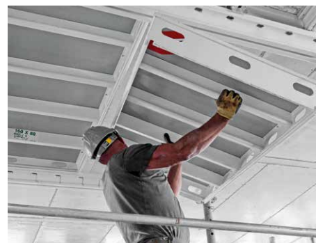
Die ergonomischen Griffprofile erleichtern das Einlegen auch von unten.
