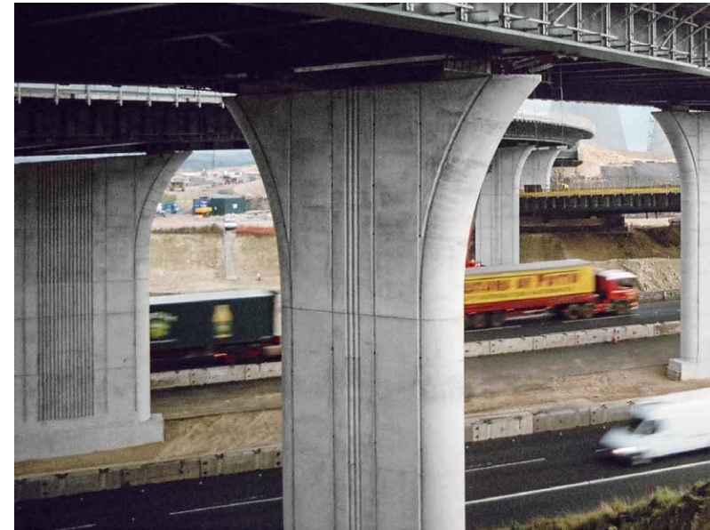
Auf Basis der Rundsäulenschalung Circo kann eine Sonderschalung für geneigte und gebogene Bauteile gefertigt werden. Hier am Beispiel Holmfield Exchange, UK.
