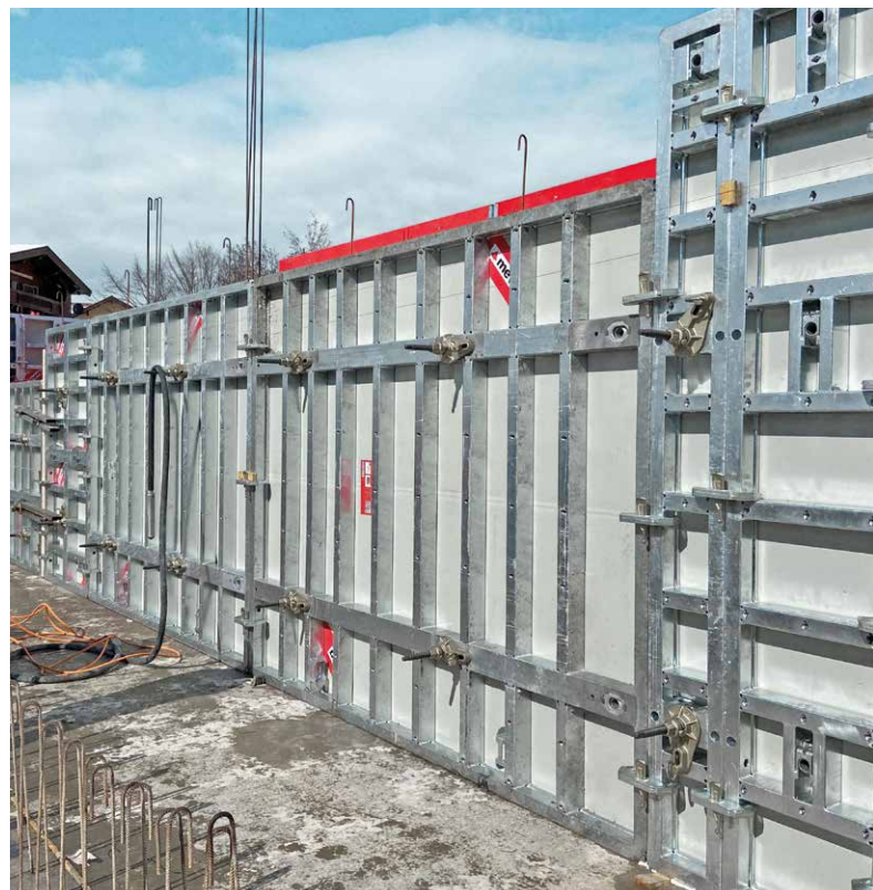
Ob stehend, liegend oder aufgestockt: Die Wandschalung mit Mammut XT und XT-Konusankerstäben beschleunigt den Baufortschritt.
