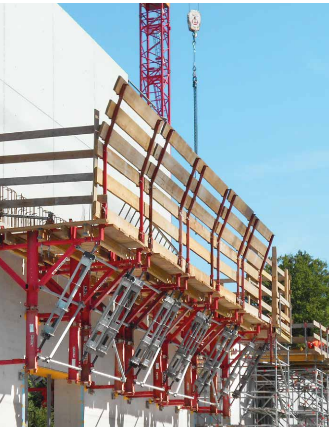
Die Kletterkonsole KLK 230 wurde als barrierefreies Arbeitsgerüst zur exakten Ausrichtung der Schalung genutzt.
