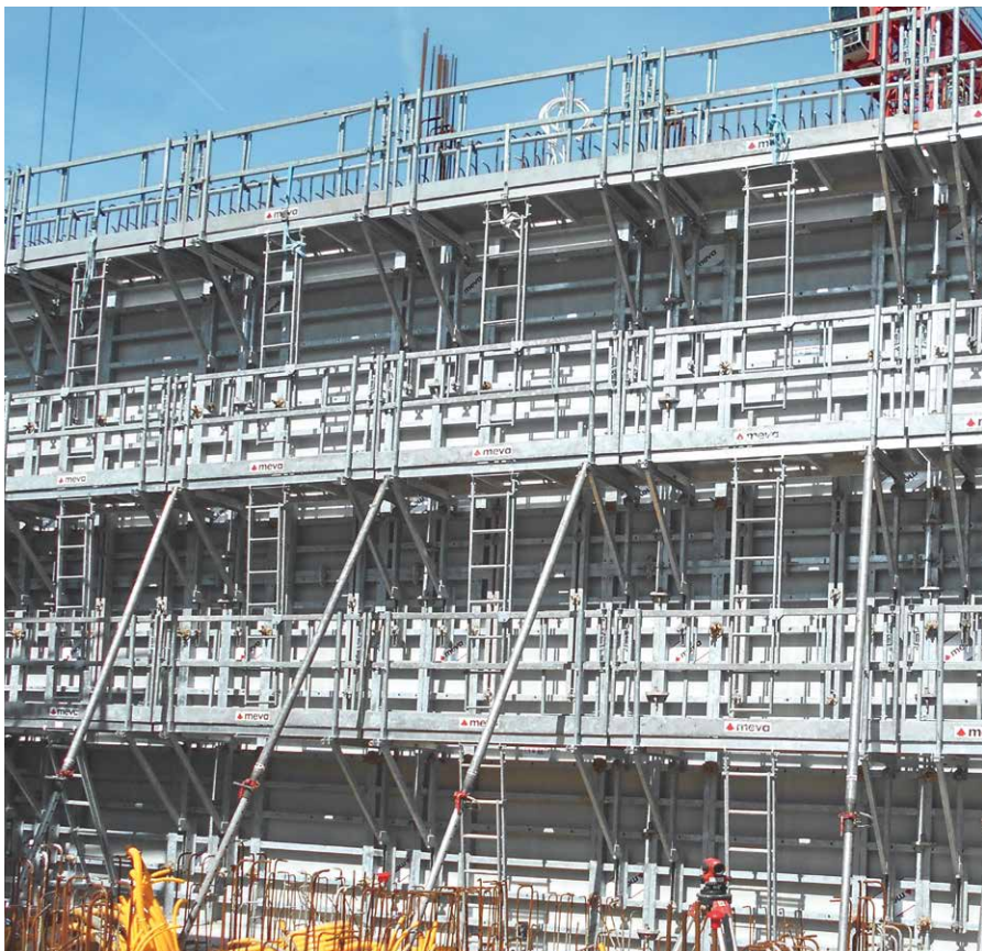
Aufgrund der hohen Maßhaltigkeit und Leistungsstärke der Mammut 350 konnte bis zu 4 m Höhe ohne Rücksicht auf Steiggeschwindigkeit betoniert werden.
